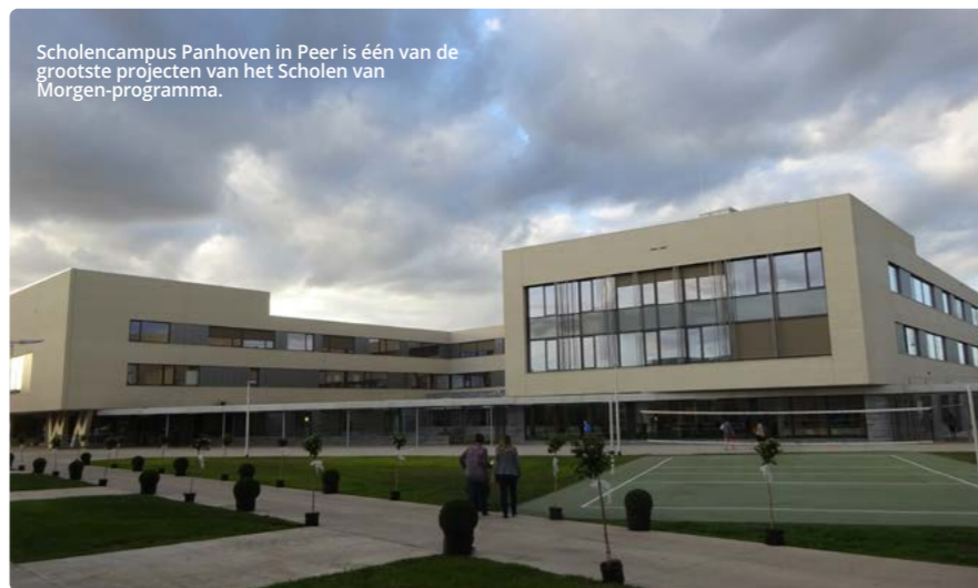
De Provinciale Kunsthumaniora in Hasselt had nood aan een nieuwbouw. Dit project wordt gerealiseerd door DBFM Scholen van Morgen. (© Ingenium)
